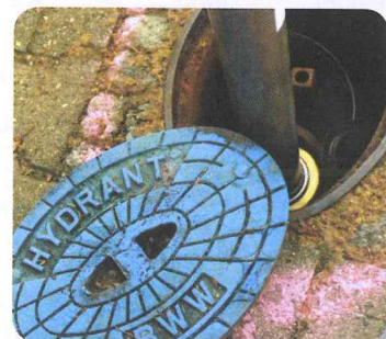
Hydrantenstraßenkappe – Zugang zum Trinkwassernetz
